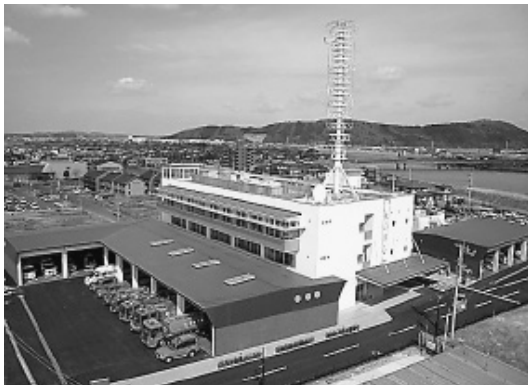
消防本部・石巻消防署
