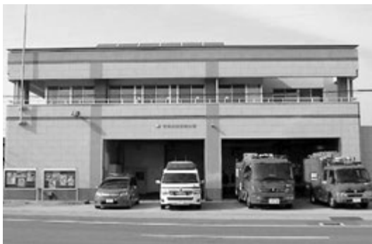
石巻消防署南分署
